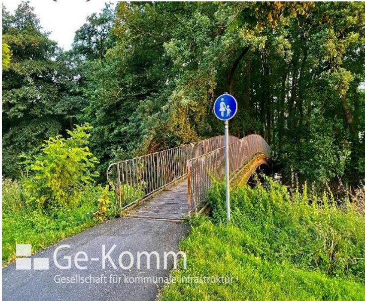
Foto: Abgängiges Brückenbauwerk über die Else im Bereich Bakumer Kirchweg
