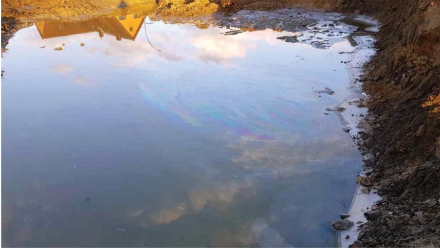
Abb. 2 (19.02.18): Die Baugrube mit etwa 0,1 – 0,2m Wasser und aufschwimmenden Ölschlieren.
