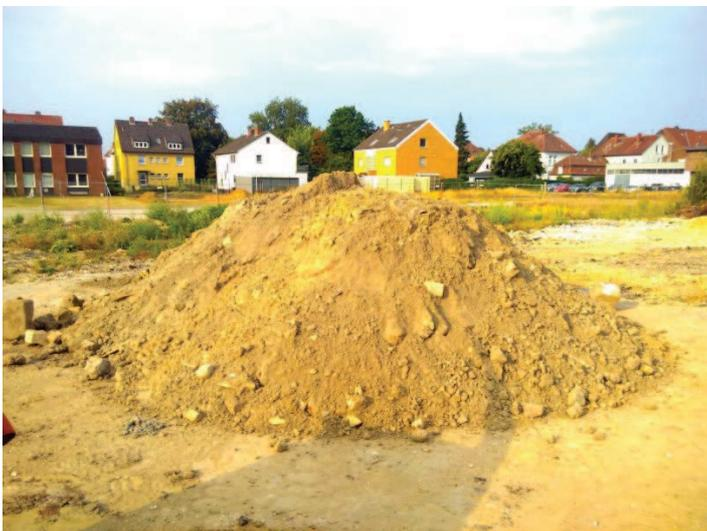
Abb. 3 (09.08.18): Ausgesondertes Material mit Asbestanteilen.
