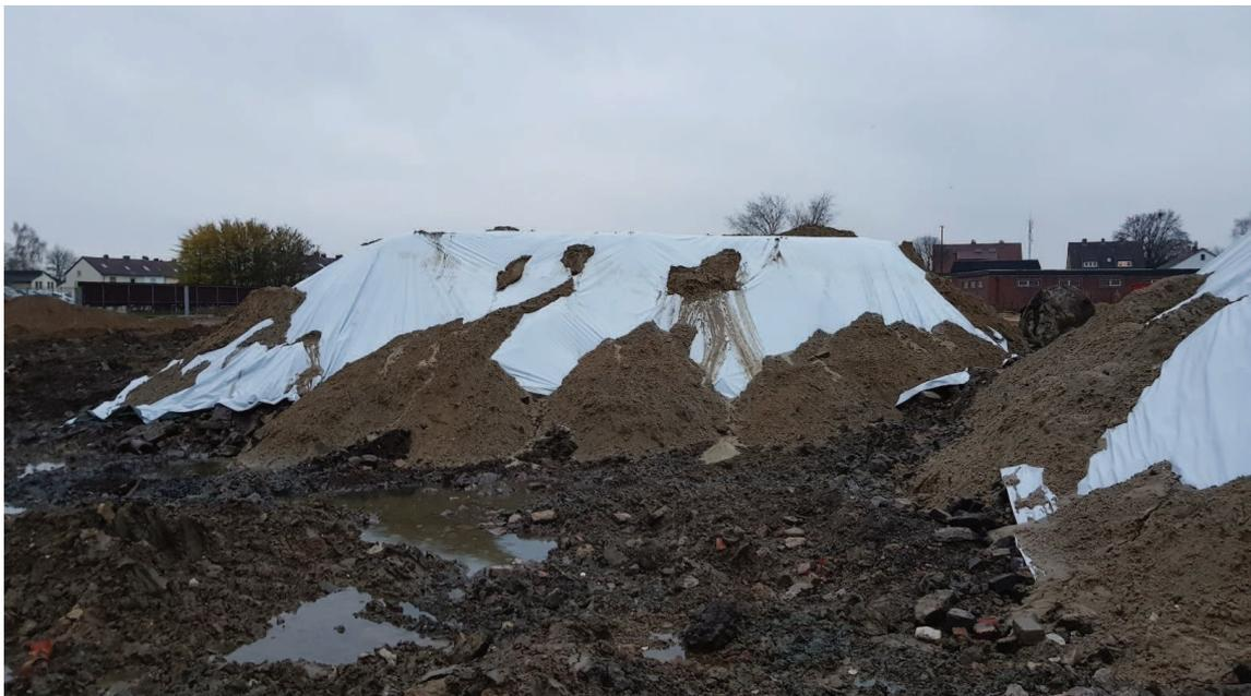
**Bild 2** (08.12.2017): Die Asbestzementbruchstücken durchsetzten Auffüllungen wurden abgezogen und bis zur Klärung der Entsorgungswege unter Plane gesichert.
