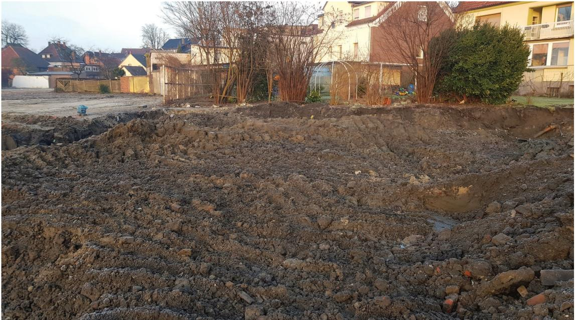
**Bild 3** (09.02.2018): Nachdem der Entsorgungsweg geklärt war wurde das aufgehaldete Material verladen. Anschließend wurde die Fläche auf Asbestzementreste kontrolliert.
