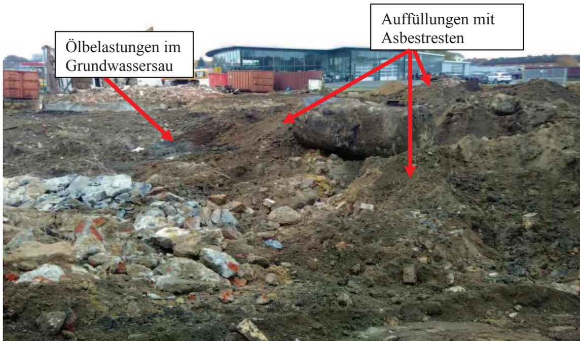
**Bild 1** (17.11.2017): Ausgangssituation - Blick auf den auffälligen Bereich der Baufläche. Der im Bild erkennbare Tank lag außerhalb der Ölbelastungen.
