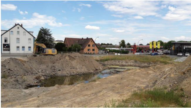
**Bild 10 (30.07.2018):** Blick über die Sanierungsfläche Richtung Nordosten. Vor dem Bagger lagert für die Verladung bereitgestelltes Aushubmaterial.
