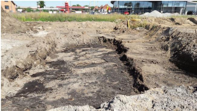
**Bild 8: (24.07.2018):** An der Basis der Ölbelastungen wurde eine torfige Schicht erreicht.
