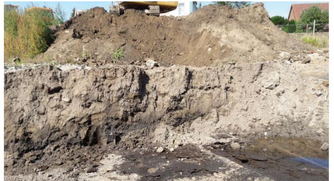
**Bild 9: (24.07.2018):** Die Stärke des ölbelasteten Bereichs betrug etwa 0,5 – 1,2m. Die Belastungen lagen auf Höhe eines Staunässehorizontes oberhalb einer tonigen, torfigen Schicht.
