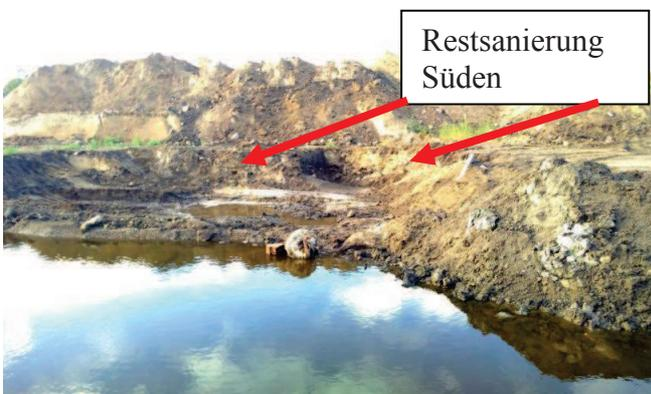
**Bild 20 (10.08.2018):** Im Süden wurden im Umfeld eines alten Drainagestrangs restliche Kontaminationen ausgehoben.
