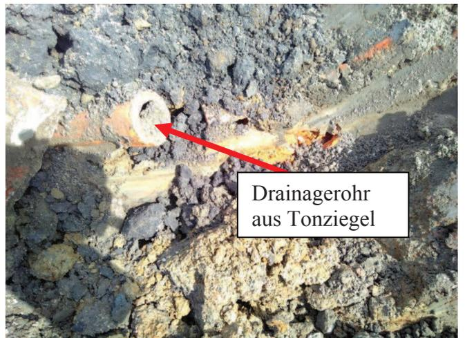
**Bild 15 (01.08.2018):** Ein altes Drainagesystem hatte offensichtlich die Ausbreitung des Ölschadens im Grundwasserschwankungsbereich begünstigt.
