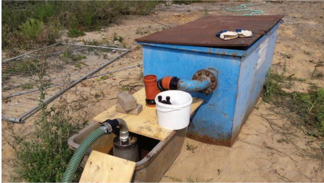
**Bild 5 (20.07.2018):** Für den Aushub des Ölschadens wurde eine Grundwasserabsenkung mit Ölabscheideranlage eingerichtet.
