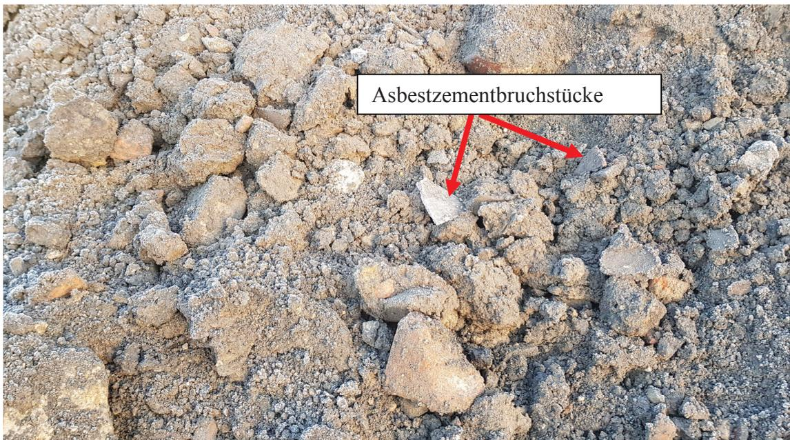
**Bild 4** (09.02.2018): In den Teilbereichen der Fläche mit erkennbaren Asbestzementresten wurde nachgearbeitet.
