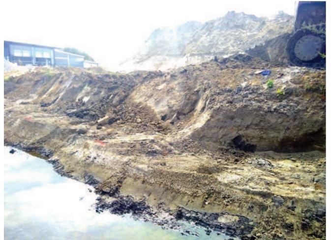
**Bild 13 (01.08.2018):** Die Wirtktiefe der eingesetzten Grundwasserabsenkungsanlage wurde erreicht.
