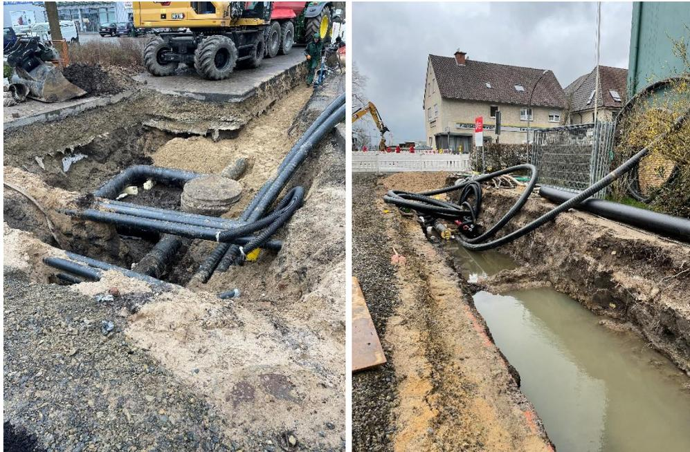
Foto 7: Baugruben an der Bismarckstraße mit verschiedenen Leitungen, Kanälen und Hausanschlüssen
