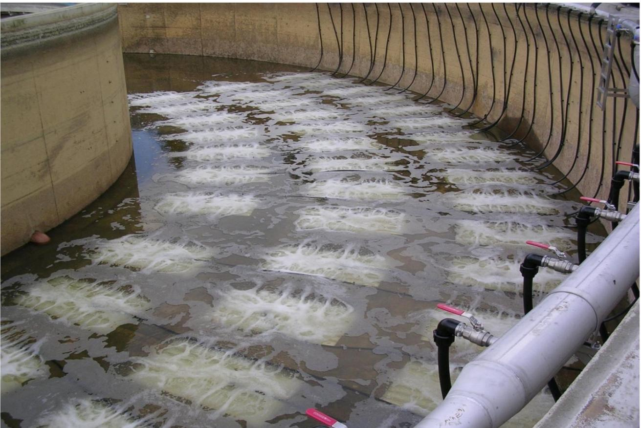
Test der Belüftungsmembranen
