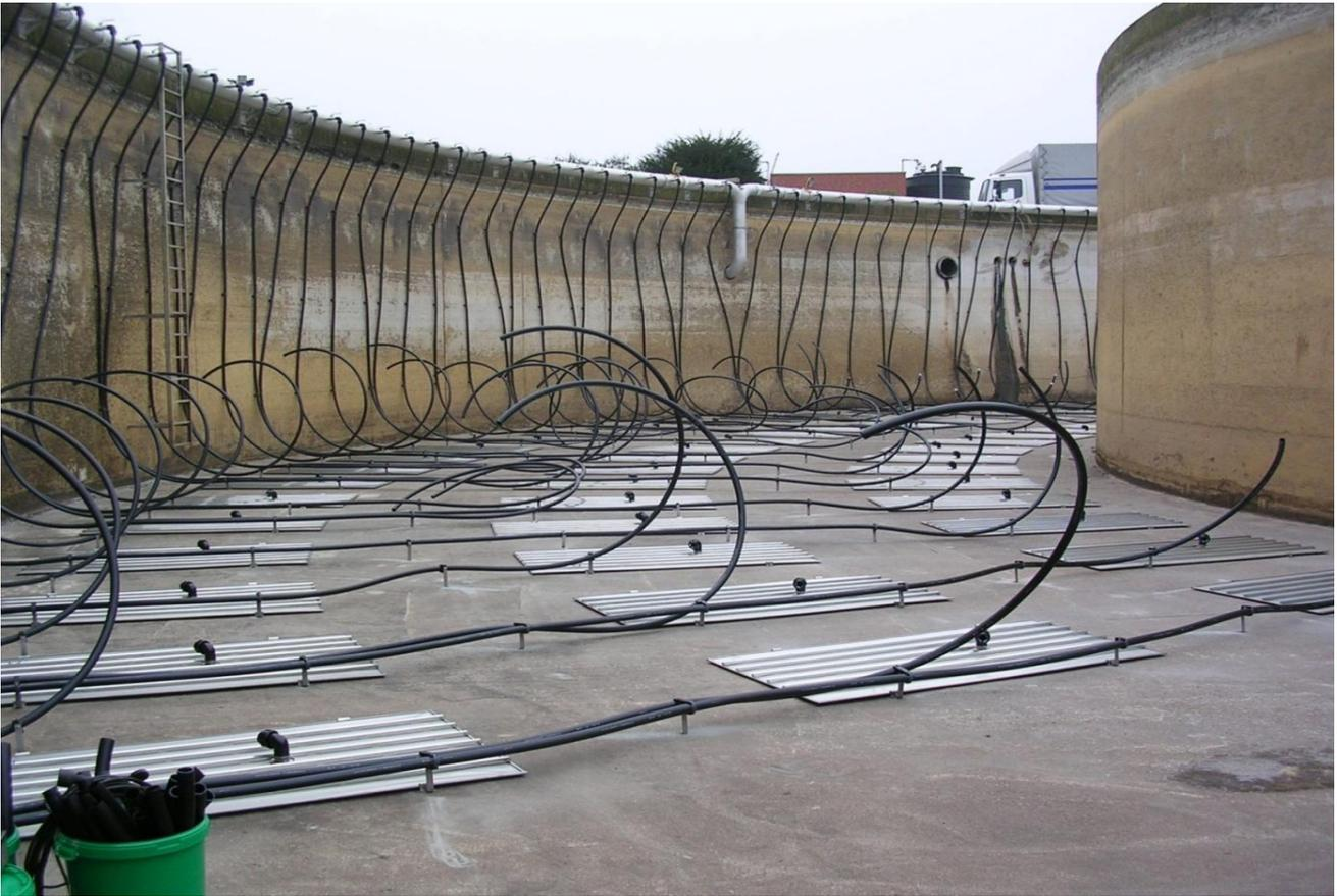
Installation von Membranplattenbelüfter auf der Beckensohle
