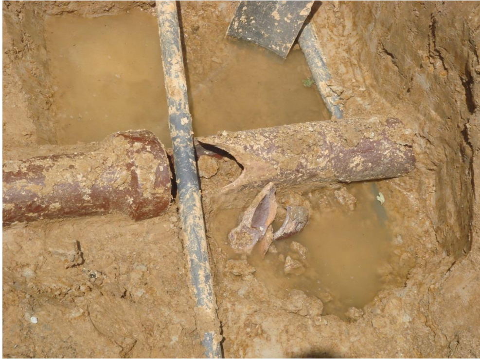
Foto 6: durchschossener Kanal
