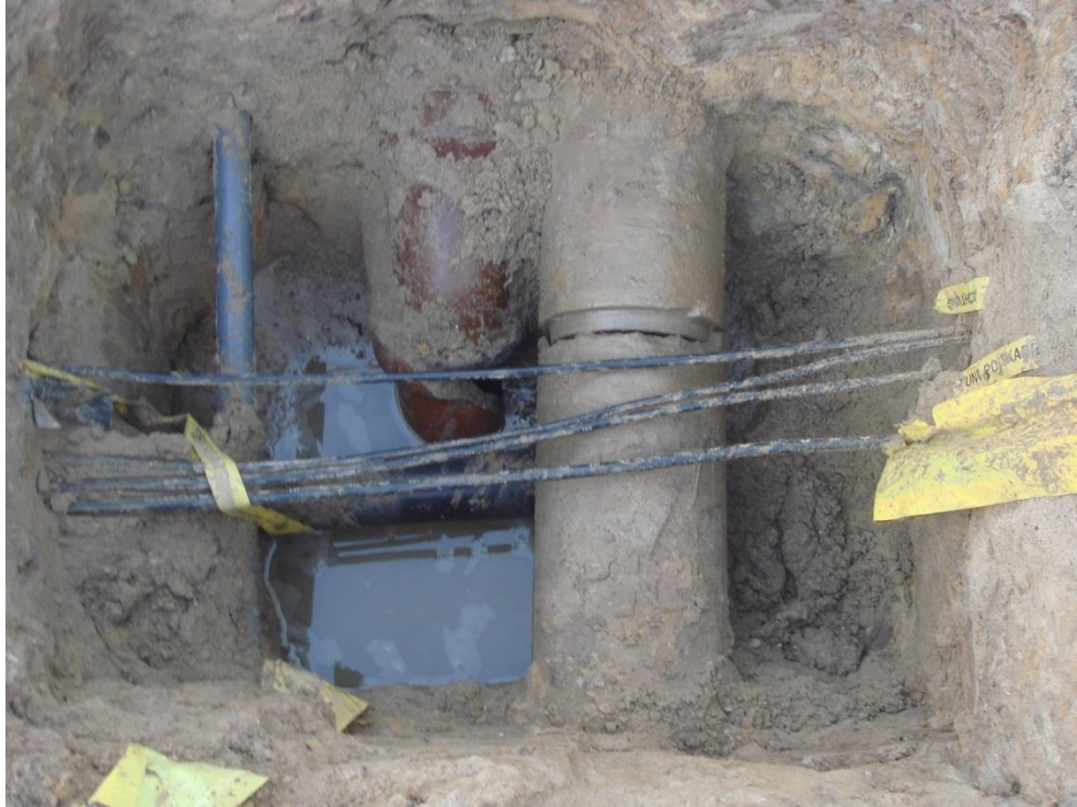
Foto 4: Baugrube mit verschiedenen Leitungen, Kanälen und Hausanschlüssen
