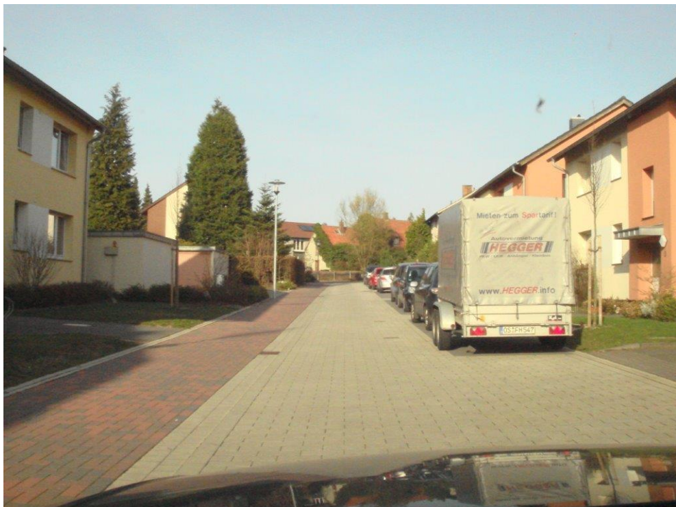
Foto 2: Bei der Mühle 2016 nach der Erneuerung mit Anliegerbeiträgen
