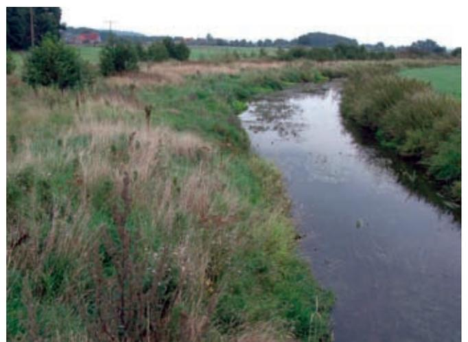
An 5 Abschnitten wurde die Elbe umgestaltet. Die Ufer wurde aufgeweitet oder abgeflacht, dem Gewässer Raum für eigene Dynamik zurückgegeben
