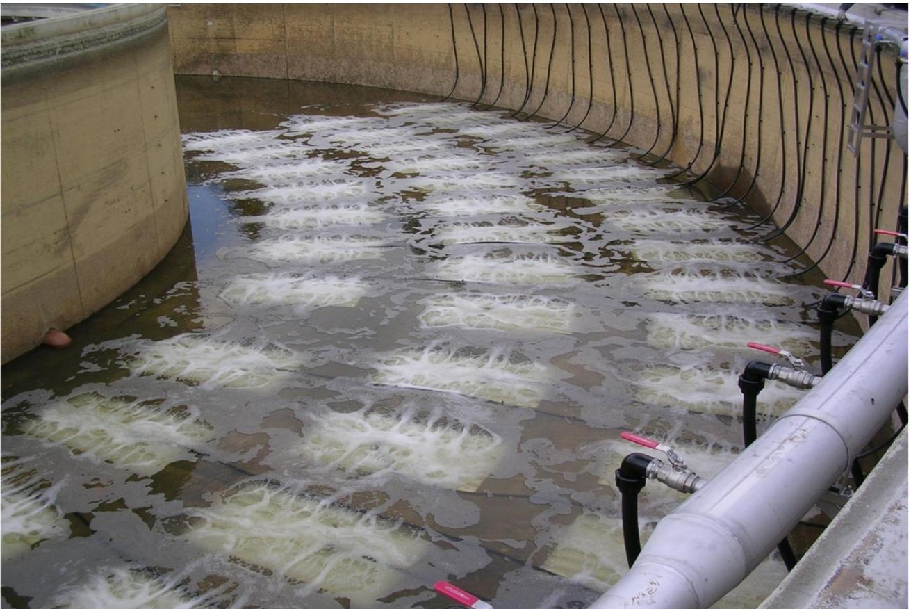
Test der Belüftungsmembranen
